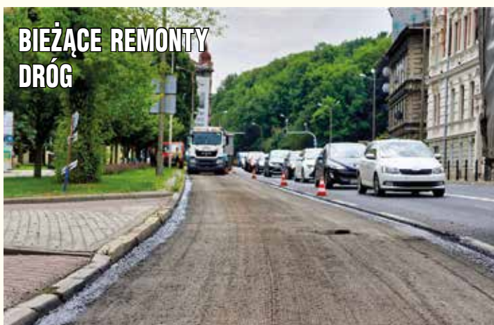
Lipcowe prace na ul. Zamkowej na wysokości placu Żwirki i Wigury
