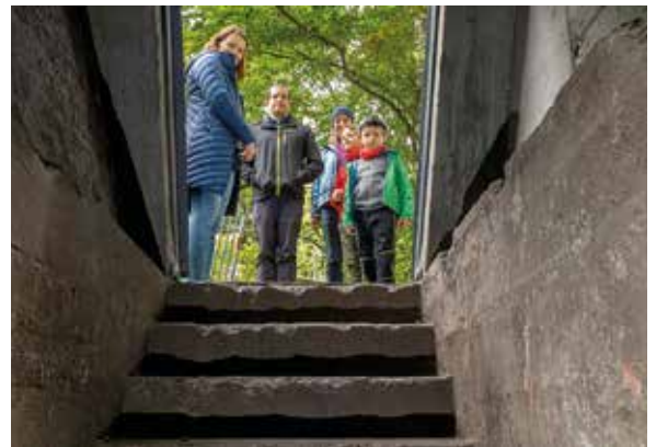
Wejście do szczeliny przeciwlotniczej
