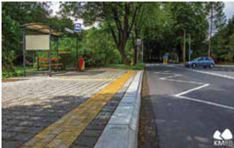
Nowy peron przystankowy oraz wiata na przystanku w kierunku Straconki, fot. Wydział Komunikacji UMBB
