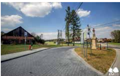
Wyremontowana pętla Janowicka Nikłowska, fot. Wydział Komunikacji UMBB
