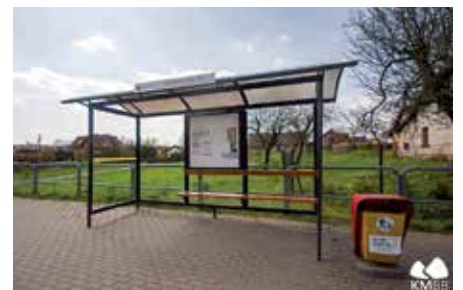
Wyremontowana wiata Janowicka Stawy (126)
