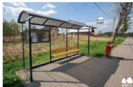
Wiata Janowicka Pod Kasztanem (128) po remoncie
