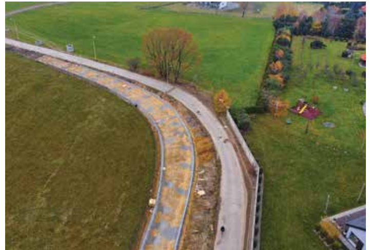
Ul. Łowiecka w trakcie remontu, fot. MZD
