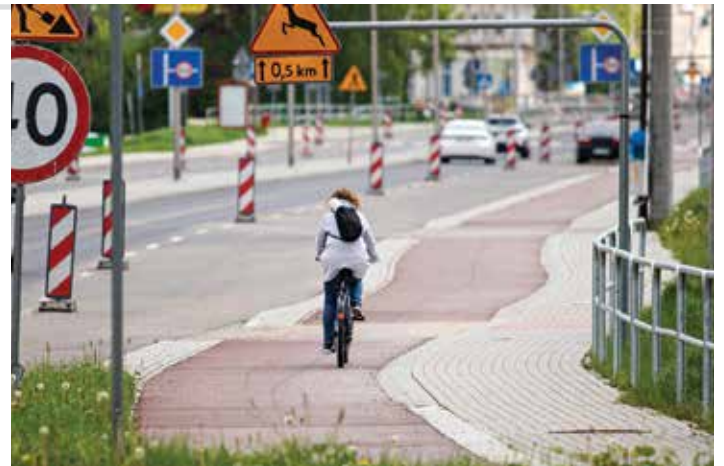
Ścieżka przy przebudowywanym odcinku ul. Cieszyńskiej
