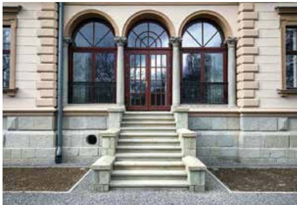
Wejście od strony ul. 3 Maja
