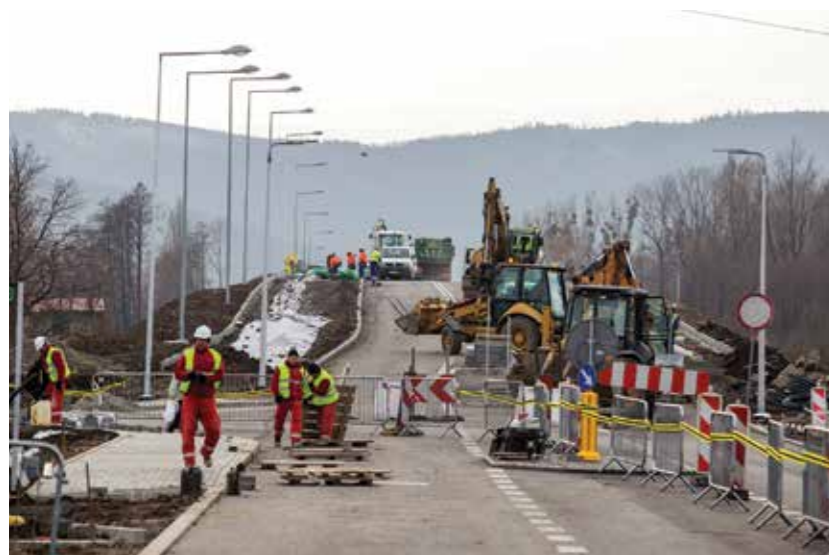
Prace na ul. Międzyrzeckiej
