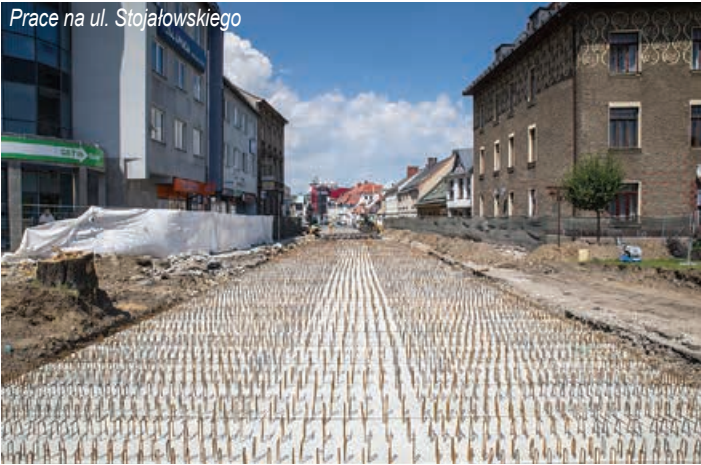
Prace na ul. Stojalowskiego
