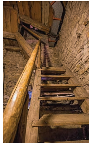
Wnętrze wieży kościoła św. Stanisława
